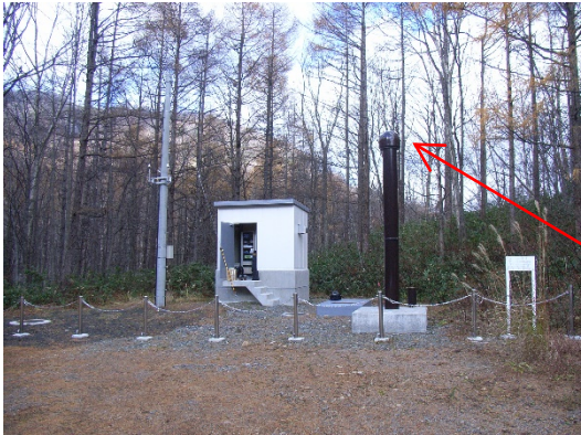
写真1 岩手山松川火山観測施設に設置されたGNSSアンテナ外観
